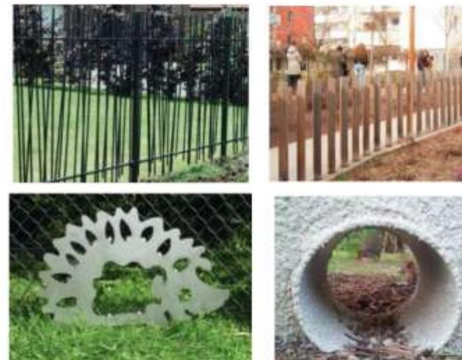
Figure 20. Exemples d'aménagements de clôture pour permettre le passage de la petite faune © illustrations extraites de la fiche technique « limiter l'impact des clôtures sur la biodiversité », Urbanisme Bâti & Biodiversité
